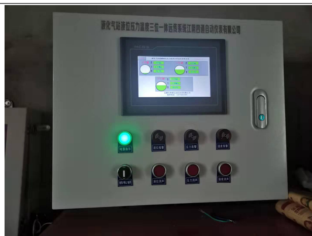
液位、压力、温度三位一体远传系统显示仪
