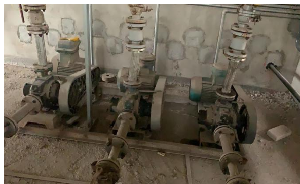
烃泵传动外侧皮带轮已安装防护罩
